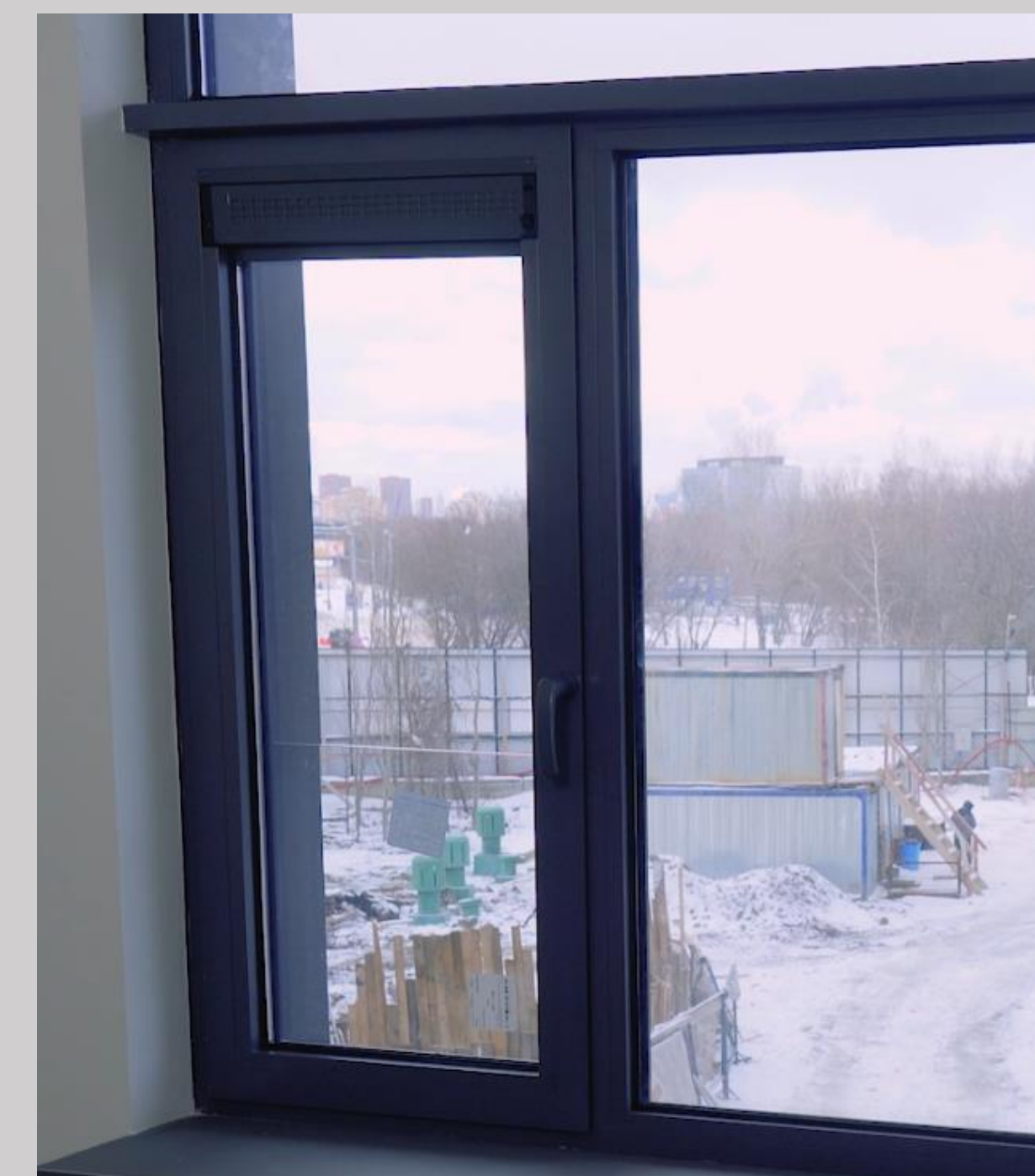
После установки проветривателя
